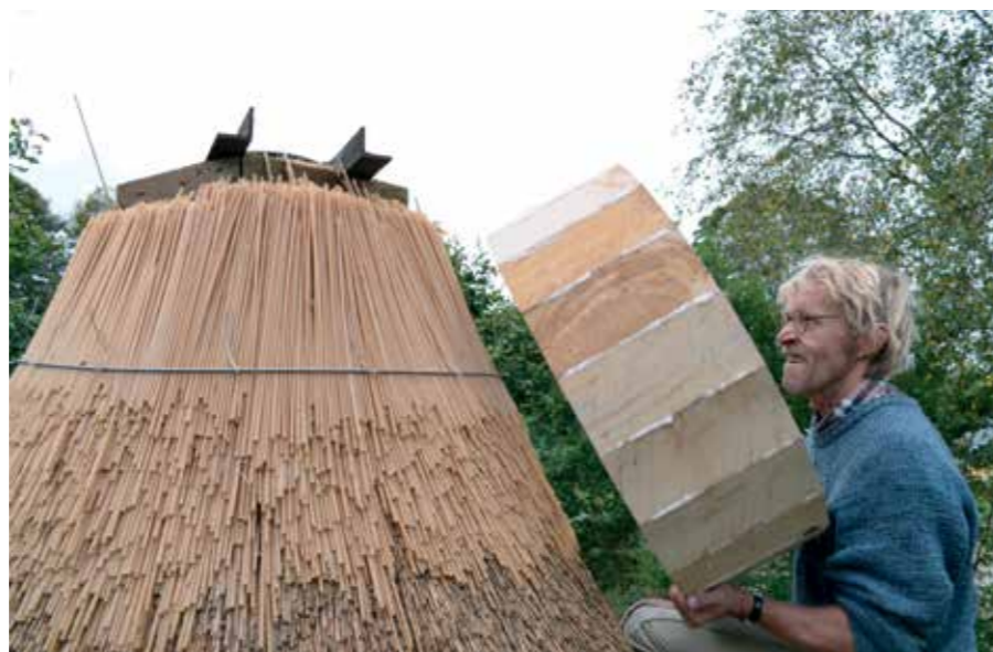
Bjarne har brugt modificerede tagrør til sidste bind, fordi der kan komme gnister op gennem skorstenen, da der er et åbent ildsted i lysthuset. Her løftes en del af "hatten" på, egetræ – som efterfølgende er pyntet med et spir oven på.
